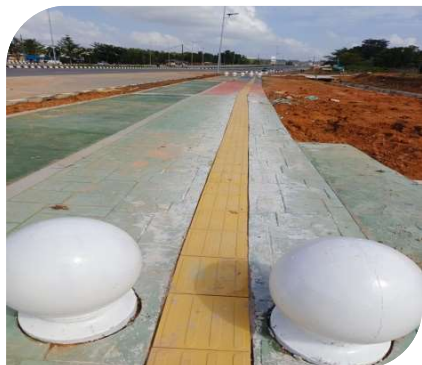
PEKERJAAN KONSTRUKSI JALAN HANG JEBAT TAHAP II (RUAS SIMP. BATU BESAR - SIMP. POLDA) PEKERJAAN: Finishing Guiding Block LOKASI : STA 1+150 Kanan
