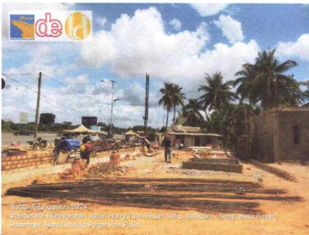
PEKERJAAN POS POLISI
