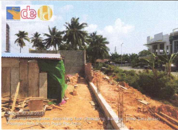
PEKERJAAN POS POLISI
