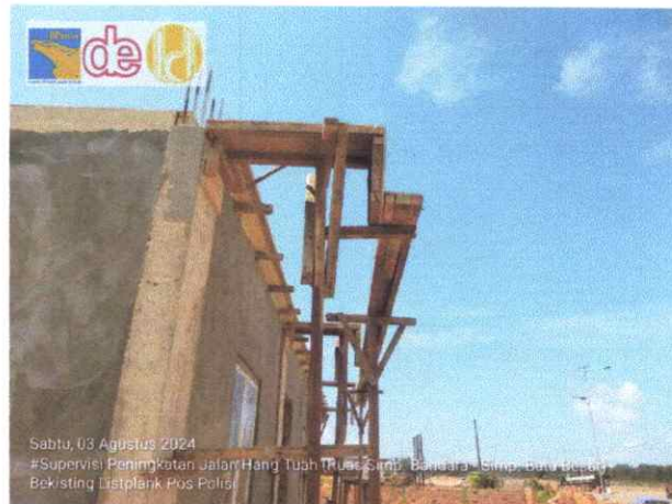
PEKERJAAN POS POLISI
