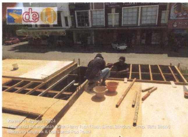
PEKERJAAN POS POLISI
