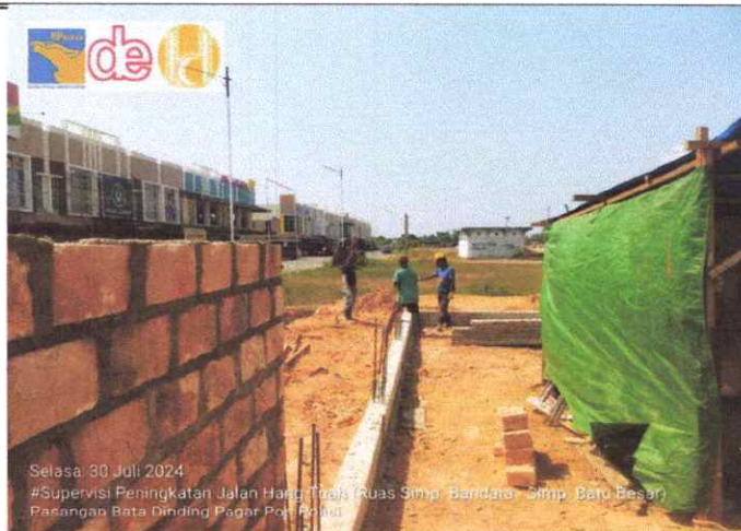
PEKERJAAN POS POLISI
