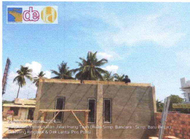
PEKERJAAN POS POLISI
