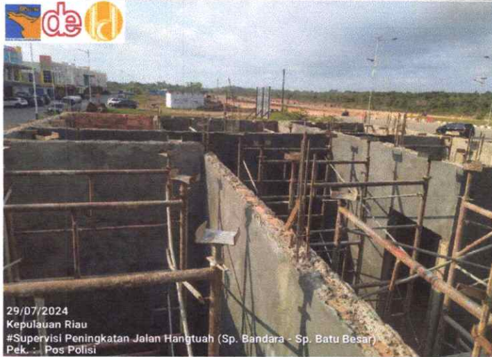
PEKERJAAN POS POLISI
