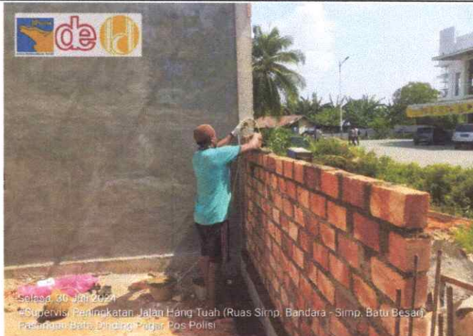
PEKERJAAN POS POLISI
