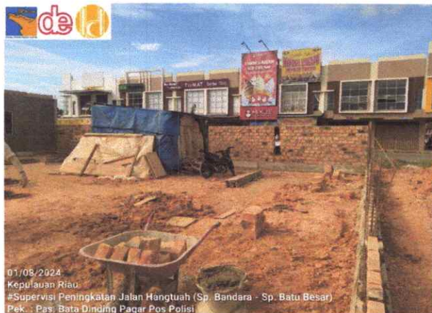
PEKERJAAN POS POLISI
