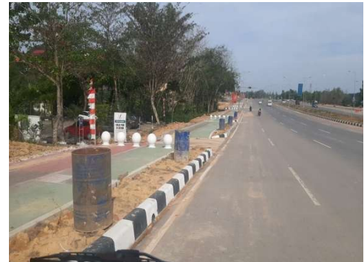
PEKERJAAN KONSTRUKSI JALAN HANG JEBAT TAHAP II (RUAS SIMP. BATU BESAR - SIMP. POLDA) PEKERJAAN: Penyiraman Pohon Median LOKASI:
