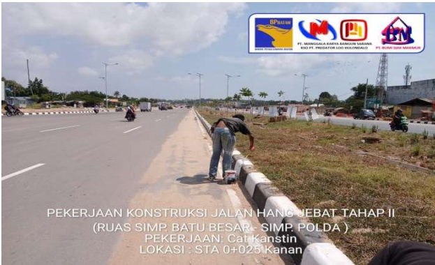
PEKERJAAN KONSTRUKSI JALAN HANG JEBAT TAHAP II (RUAS SIMP. BATU BESAR - SIMP. POLDA) PEKERJAAN: Pengecatan Kanstin LOKASI : STA 0+025 Kiri
